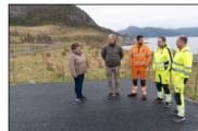
Fylkesveier underveis på Kvamsøysa. Her er trossen på øya, alle Røstebund fast. FOTO: INDER VIKEN
