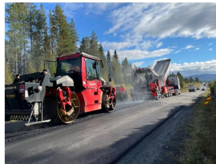
Illustrasjonsbilde. Asfaltering av E14 i Trøndelag. Uttesting av biogent bindemiddel høsten 2021. Foto: Ellinor Hansen
