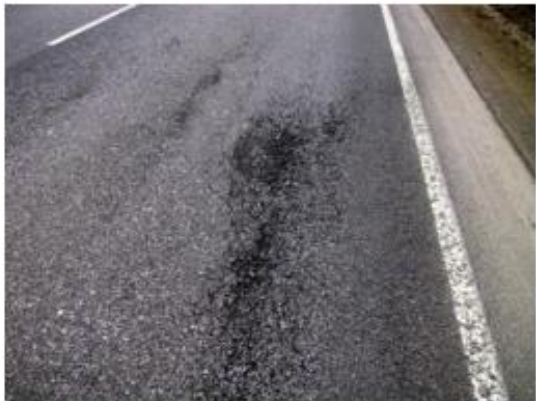
Separasjon Weathering
