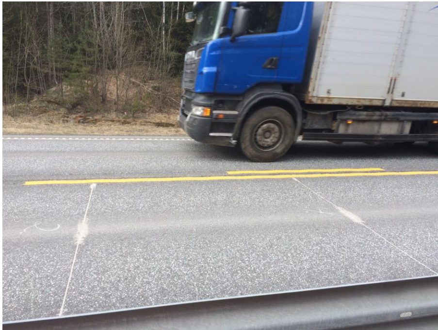
Piezoelektriske kabler på E18 Dørdal
