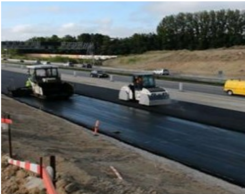
Asfaltutlegning, fresing og vedlikehold av gml. asfalt
