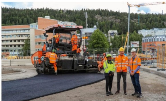
När Peab Asfalt lägger den första
