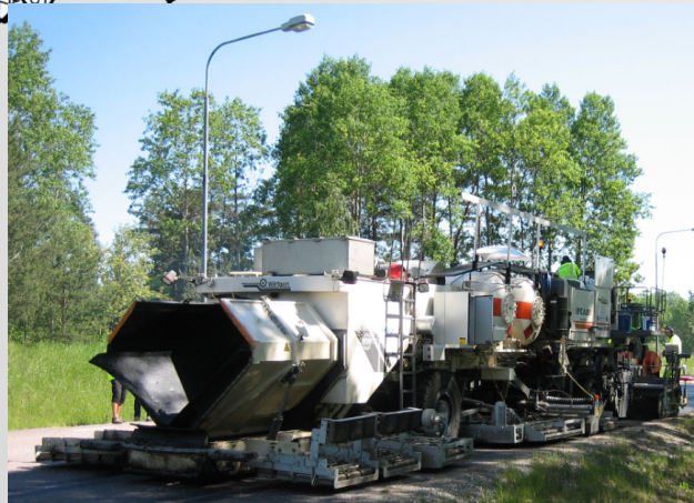
Remixing SMA 16 med emulsion
