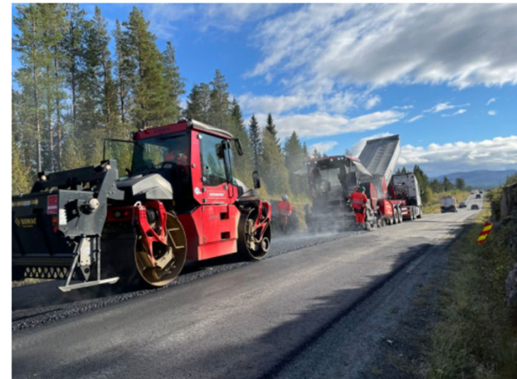
Illustrasjonsbilde. Asfaltering av E14 i Trøndelag. Uttesting av biogent bindemiddel høsten 2021. Foto: Ellinor Hansen
