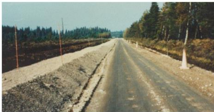
Figur A6.7 Forbelastning ved breddeutvidelse over myr. [19]
