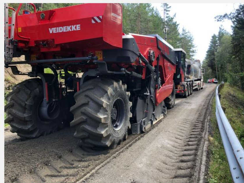
8,5 kilometer av fylkesvei 162 i Nordre Land forsterkes nå med dypstabilisering. Foto: Statens vegvesen
