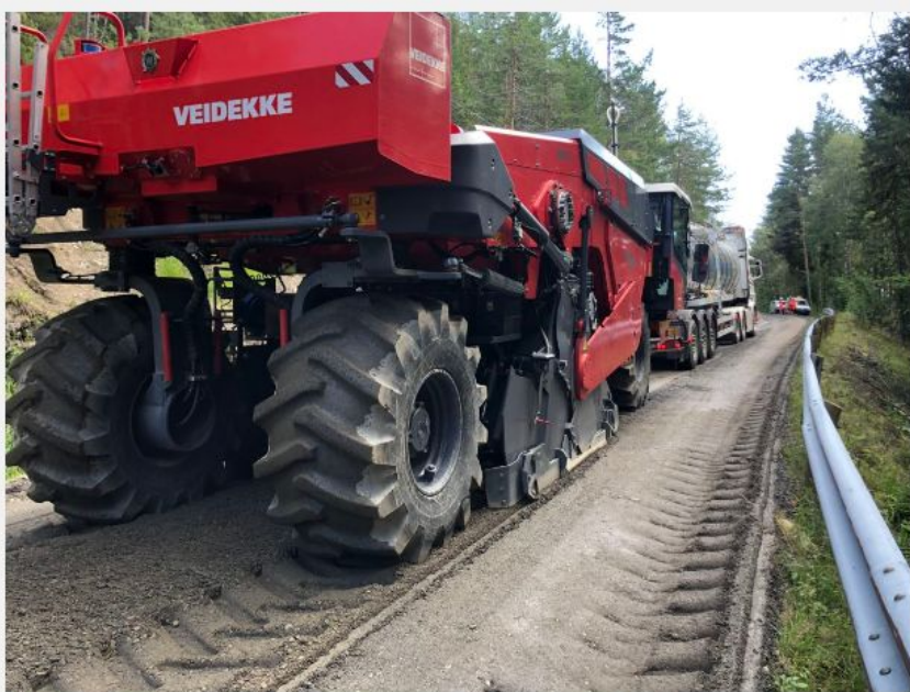
8,5 kilometer av fylkesvei 162 i Nordre Land forsterkes nå med dypstabilisering. Foto: Statens vegvesen
