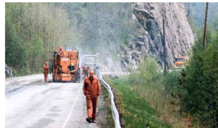
Asfaltfresing på E18 ved Songe i Tvedestrand, 1984.
