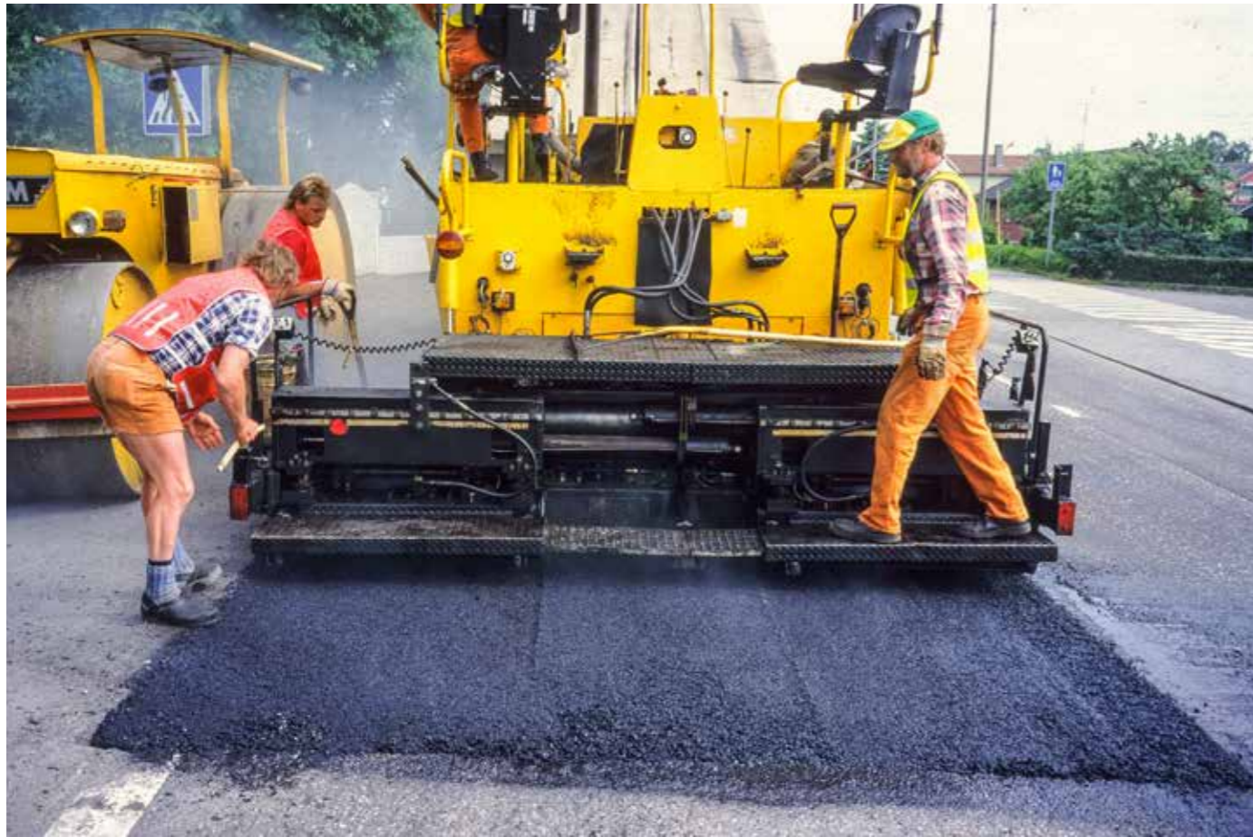
Fjeldhammer Brug utførte forsøk i Grenland med massetypen IcoTop i 1994.
