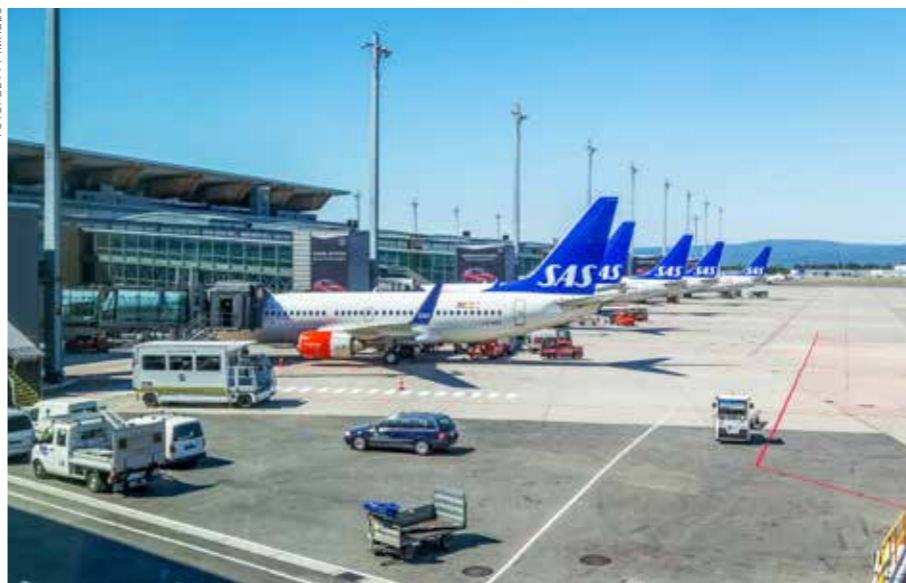
I 1998 ble det lagt over 300 kilometer med asfalt rundt terminalen på Gardermoen. Mest asfalt gikk det med til den nye rullebanen.
