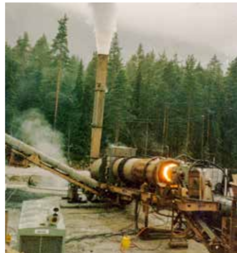
Asfaltproduksjon i Skomedal grustak, Setesdal, 1988.
