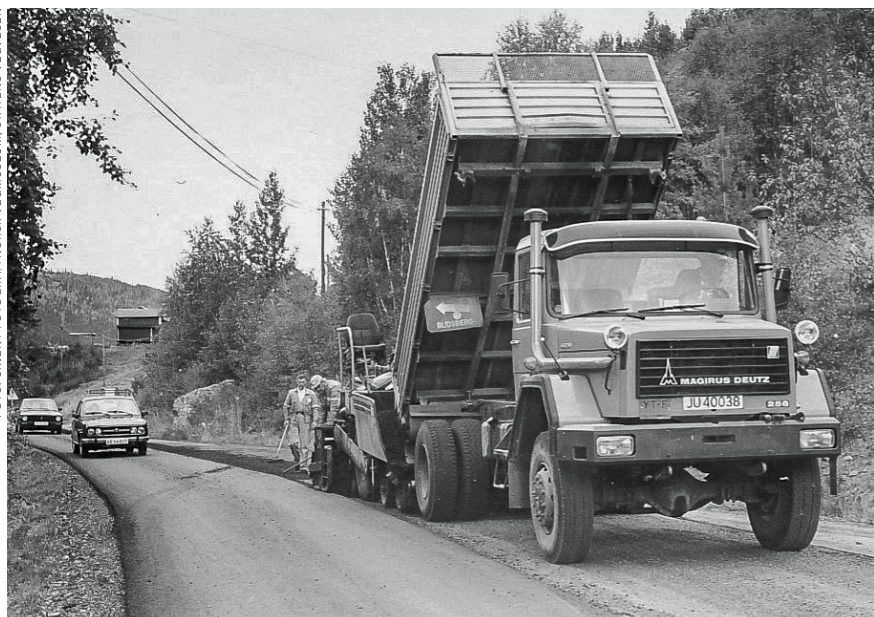
Asfaltering av vei i Buskerud på 1980-tallet.
