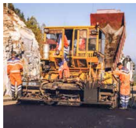
Utbedring av fylkesveg 812, Dugnadsvegen i Saltedal i 2002.
