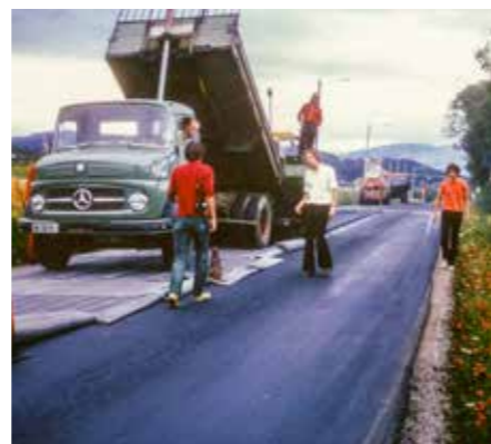
Utlegging av armeringsnett på riksveg 80 i Bodø i 1974.
