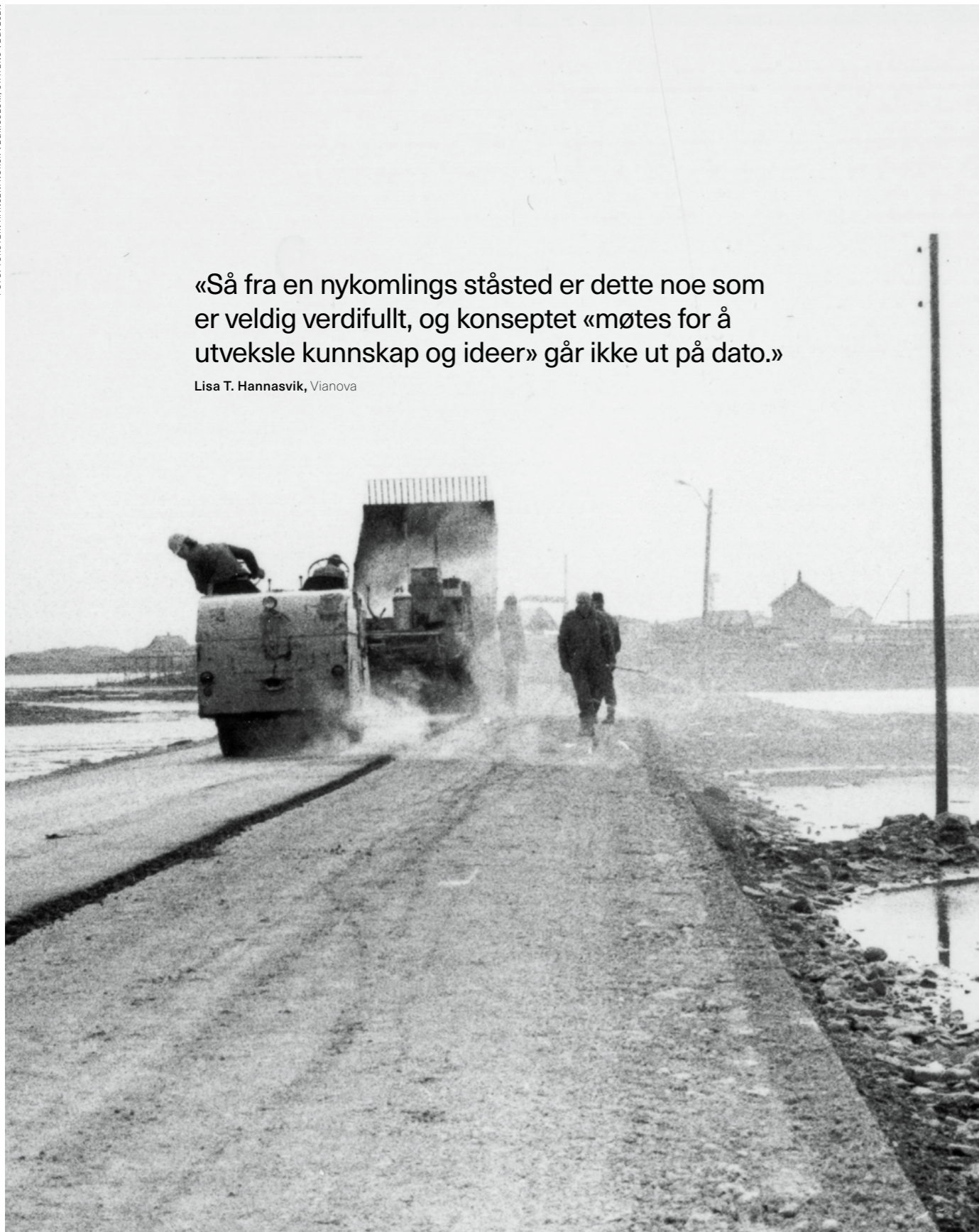
Dekkelegging i Røst Nordland, 1973.
