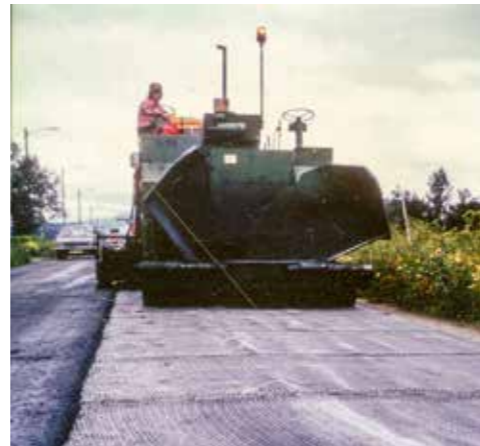
Utlegging av armeringsnett på riksveg 80 i Bodø, 1974. Bildet viser de første prøvene med armering av asfalt (Hatelitt fiberarmering). Forsøket var vellykket og strekningen på cirka 400 meter er fortsatt under trafikk. Asfaltarbeidet ble utført av Nordasfalt.
