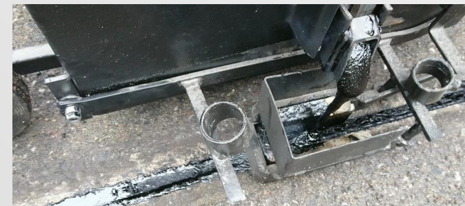
Oppvarming og utlegging ny fuge, fra 5 mm sprekker
