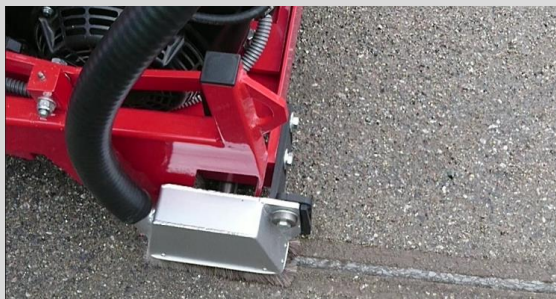
Fresing av sprek/fuge
