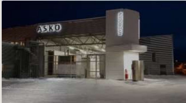
Fyllestasjoner for tunge hydrogenkjøretøy
