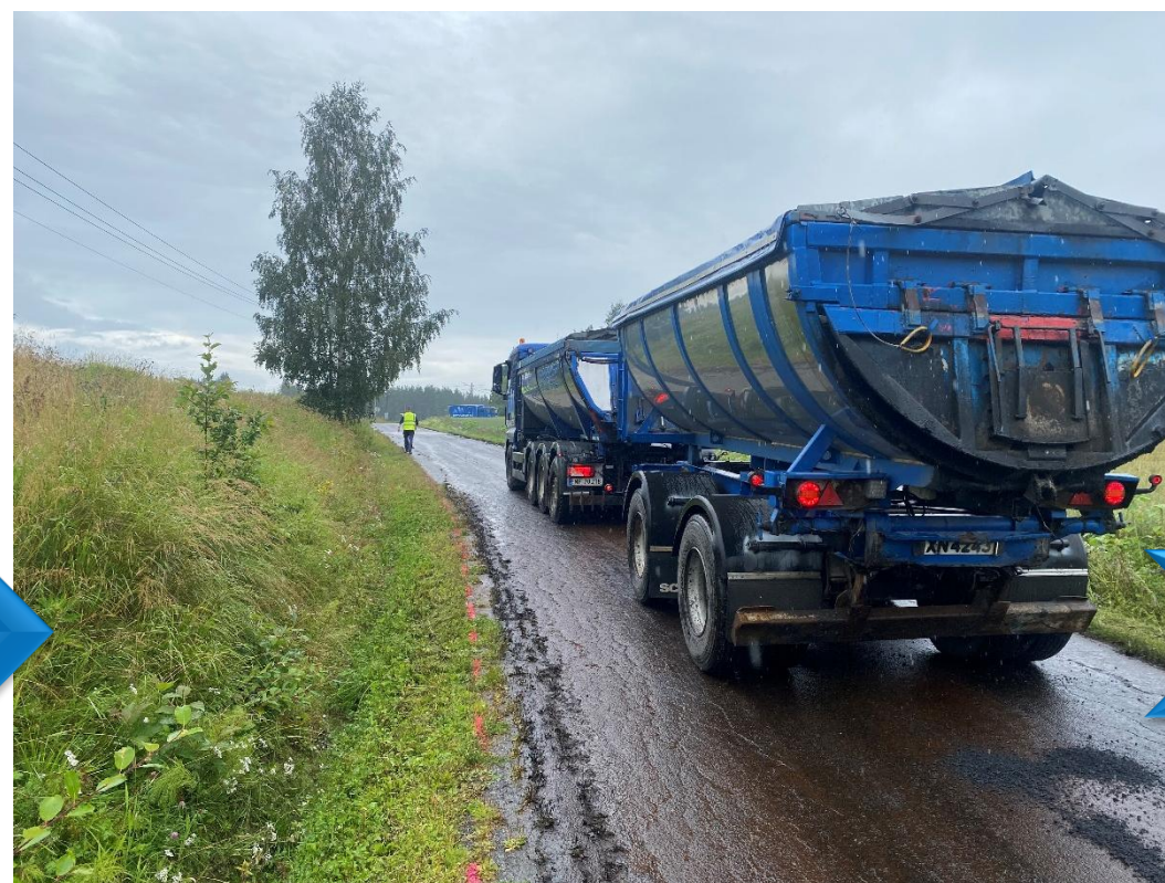
2023 – Nedbrutt veidekke før restaurering
