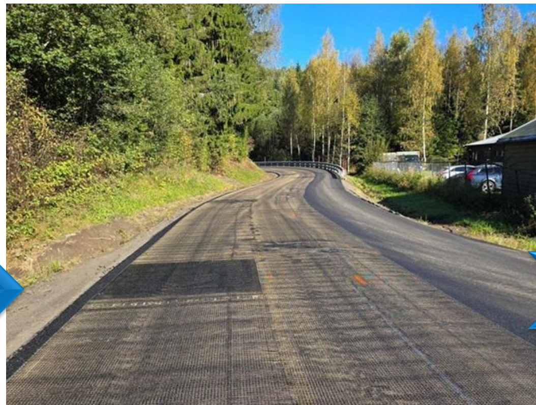
2025 – Armert veidekke før asfaltering
