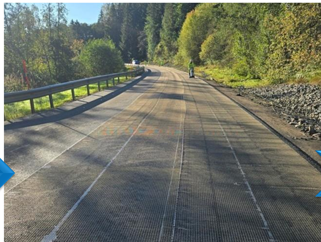
2025 – Armert veidekke før asfaltering
