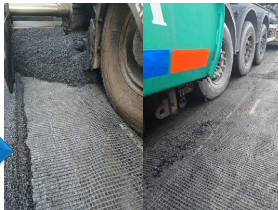
Utlekking av asfalt på armering
