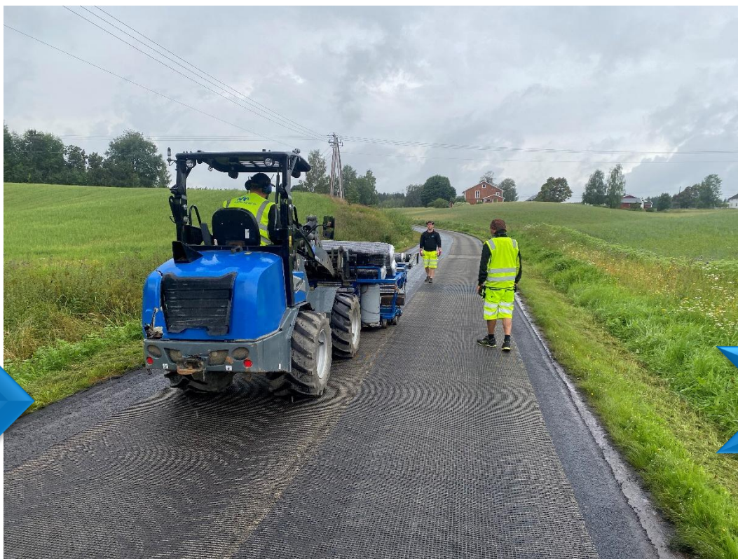
2023 – Utlegging av armering på avrettet vei
