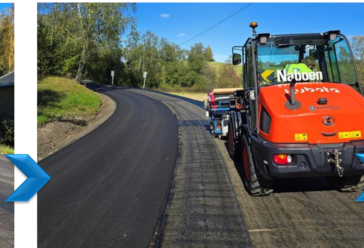
Utlekking av armering på utjevnet vei
