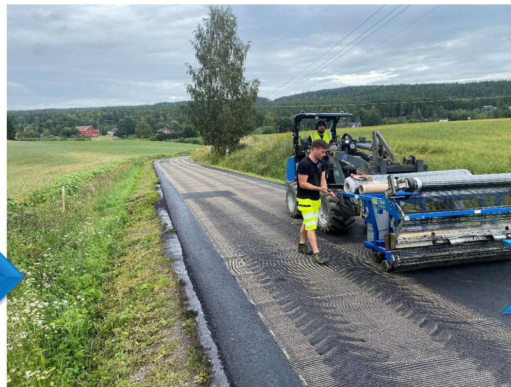
2023 – Utlegging av armering på avrettet vei
