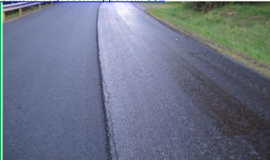
Riktig: Klebingen dekker hele arealet som skal asfalteres (foto: Frode Malmstrøm)
