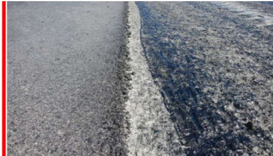
Feil: Det er ikke klebet under skjøt. Dette vil kunne føre til slipp mellom asfaltlagene (foto: Roar Telle)
