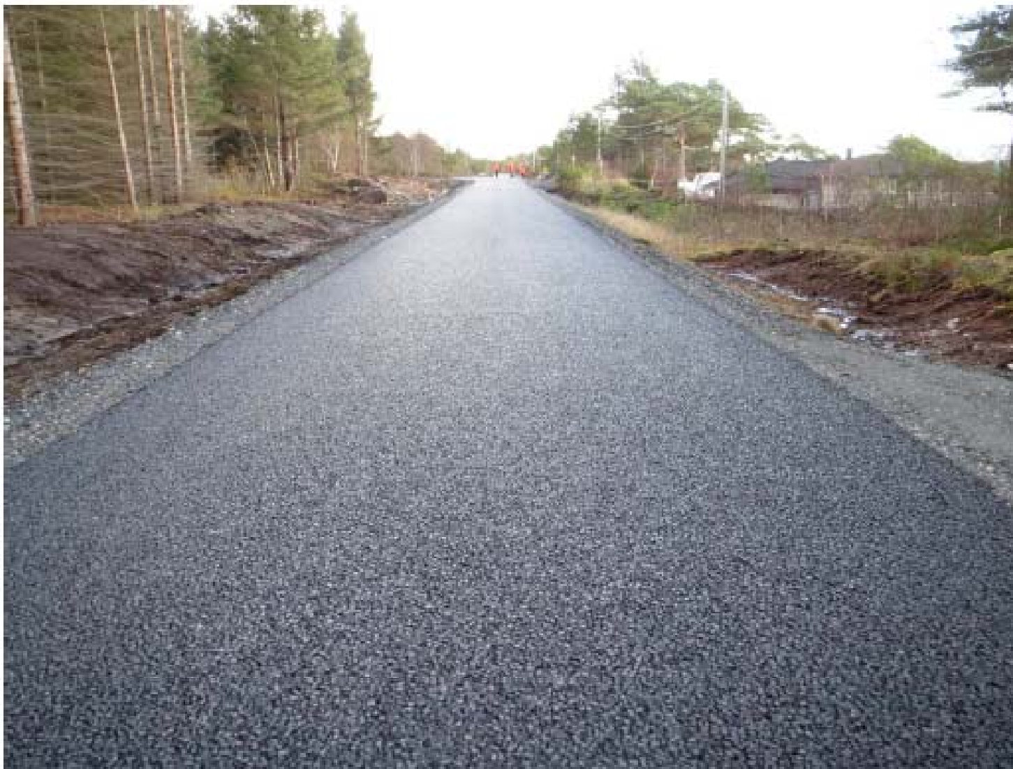
God utførelse, homogent asfaltdekke (foto: Jan Sundstrøm)
