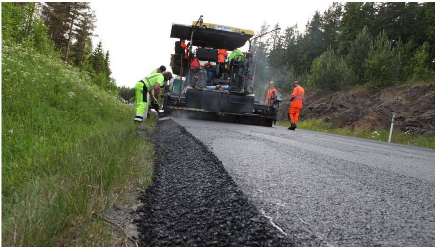
Foto: Peab Asfalt
