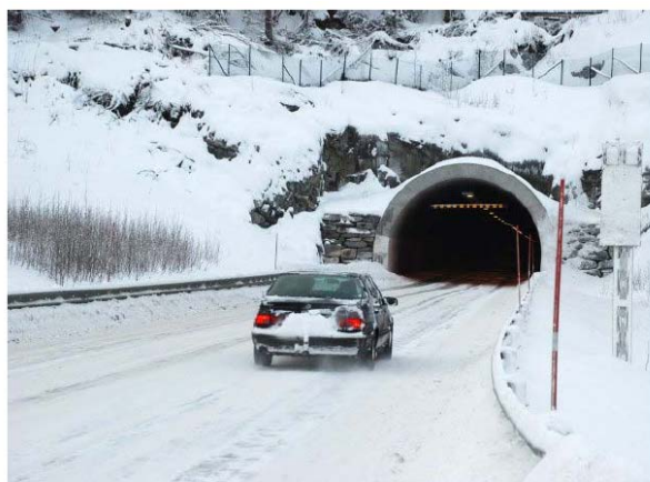
En issvull nærmere 700 meter inn i Korgfjelltunnelen fra nordsiden førte til et trafikkuhell torsdag ettermiddag der en bil kjørte inn i bergveggen. Foto: Klaus Solbakken
