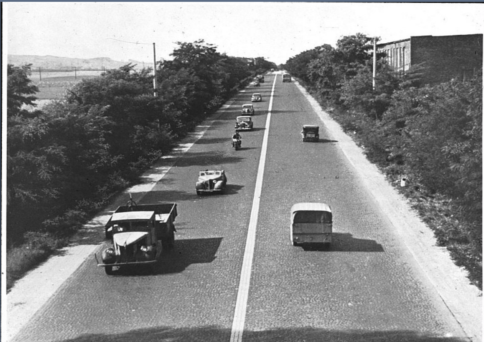
«Autobahn» fra 1934 med Basalt- smågatestein
